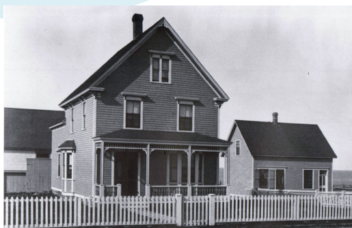
Photographie ancienne qui illustre la forme de toiture la plus répandue : celle dite à pignon à pentes prononcées.
