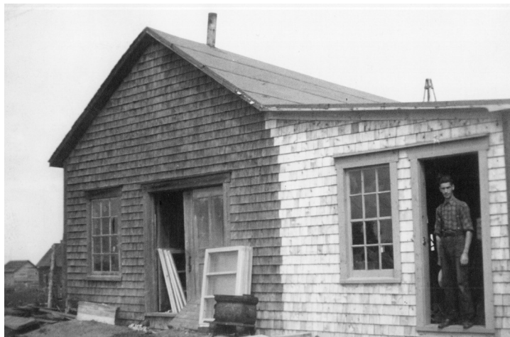
Photo ancienne d'une menuiserie, qui montre, à droite, les travaux de remplacement du revêtement de bardeau de bois, une opération toujours possible de nos jours.
