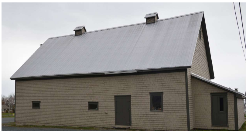
Bel exemple d'un bâtiment bien conservé et recyclé pour de nouvelles fonctions utilitaires. La présence des événements de toiture rappelle l'usage original de grange-étable nécessitant la ventilation naturelle du bâtiment.
