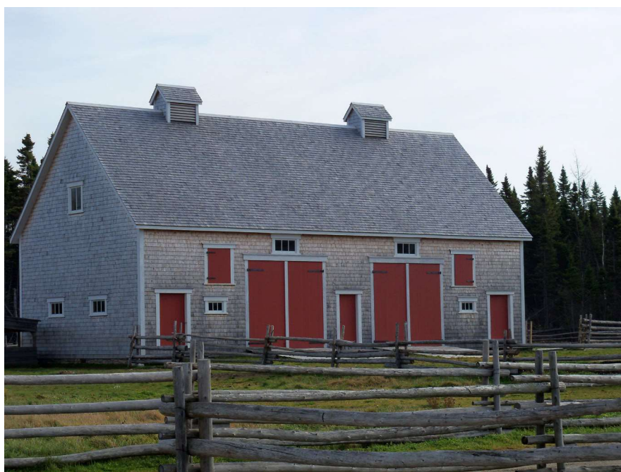
Superbe exemple d'une grange étable originale déménagée au Village historique acadien et restaurée avec soin avec les matériaux appropriés.
