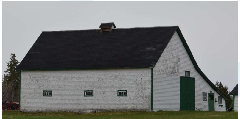
Belle grange étable, en excellent état, dont la faible élévation du sol demande de dégager le pourtour du bâtiment pour favoriser l'assèchement du bas du revêtement des murs.
