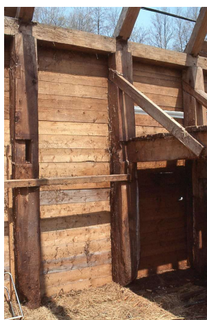
Ossature de poutres et poteaux
