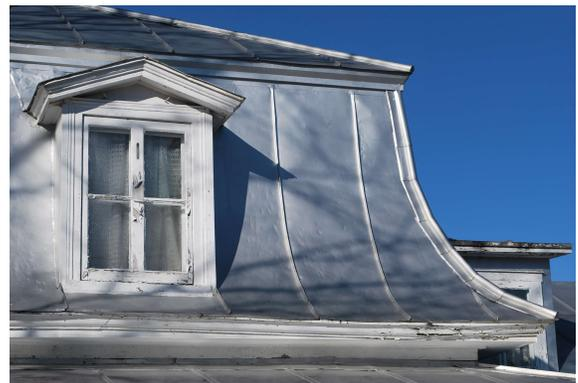
Couverture de tôle à joint pincé
